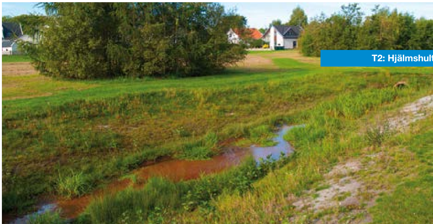
Detta dagvattenmagasin i Hjälmshult är utformat som ett tvåstegsdike.
