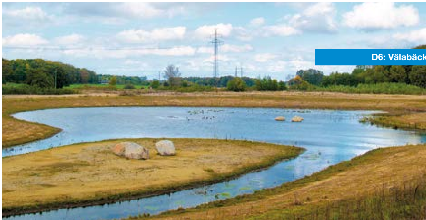
Dagvattendammen vid Välabäck.
